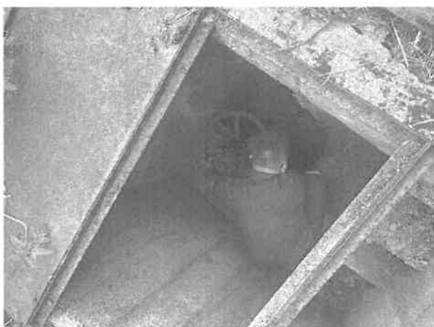
(8)关闭污水排放口
